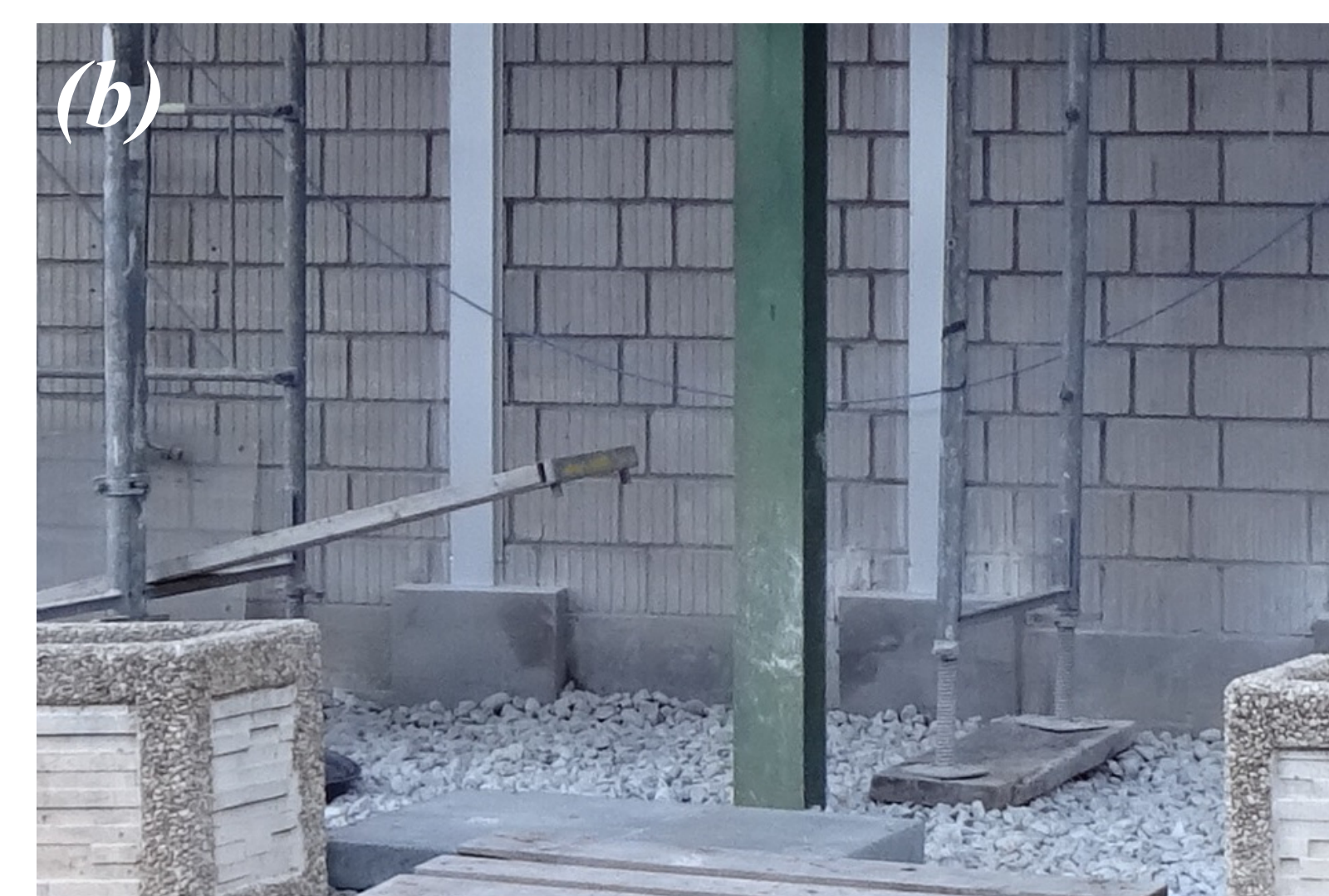
Photos de la solution utilisée pour l'introduction des efforts de précontrainte (a) au sommet et (b) à la base du voile en maçonnerie.
