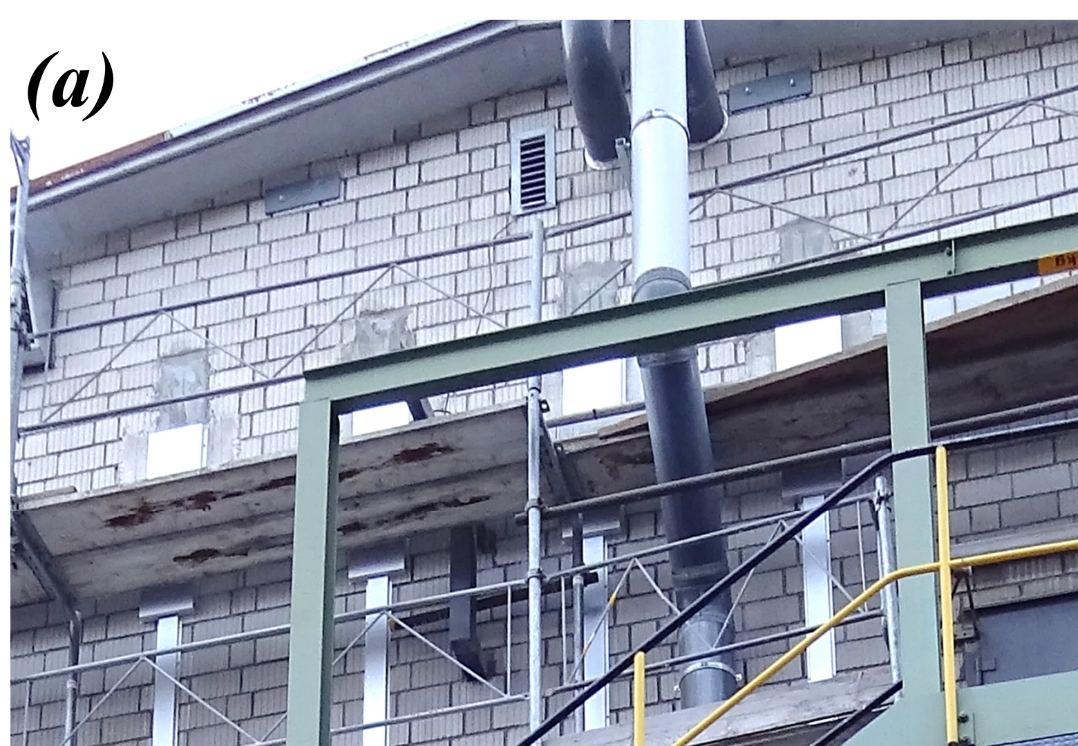
Photos de la solution utilisée pour l'introduction des efforts de précontrainte (a) au sommet et (b) à la base du voile en maçonnerie.
